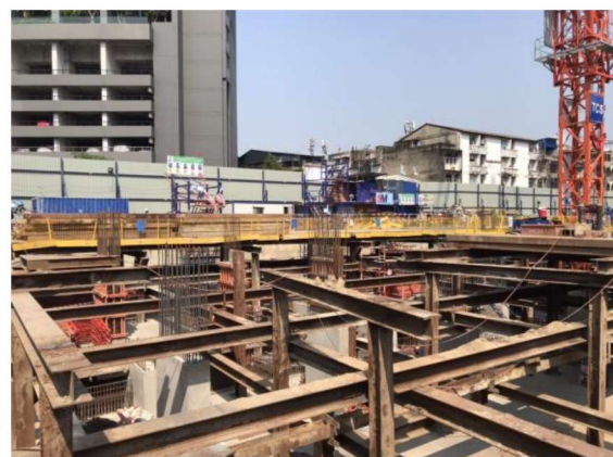
งานรื้อระบบค้ำยัน (Bracing และ Platform)
